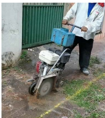
Figura 6 - Corte de pavimento com disco adjacente à localização prévia da rede existente
