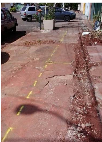
Figura 5: Tubulação e ramal localizados e demarcados no solo à tinta com execução de rede nova em paralelo
