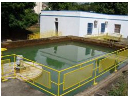
Figura 2 a) Decantação na ETER e b) Retorno da água decantada para a entrada da ETA.
