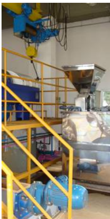
Figura 3 a) Tanque decantador/misturador b) Casa de Desidratação e c) lodo desaguado.
