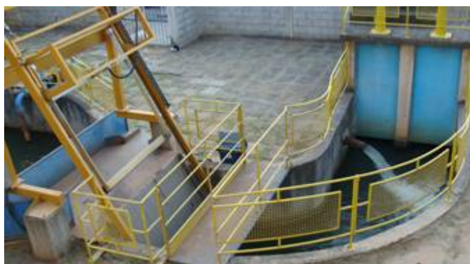
Figura 2 a) Decantação na ETER e b) Retorno da água decantada para a entrada da ETA.
