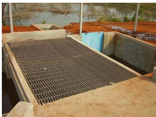
Foto 05 - Vista de uma das caixas de retenção, prontas, com a tampa, prontas com capacidade da caixa: 30.000,00 litros. Fonte: PHELPS, Cláudio.
