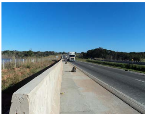
Figura nº 03 – Vista de uma das estruturas New Jersey, à margem da rodovia, num dos pontos de travessia sobre o reservatório. Fonte: SANEAGO, Henrique Araújo.
