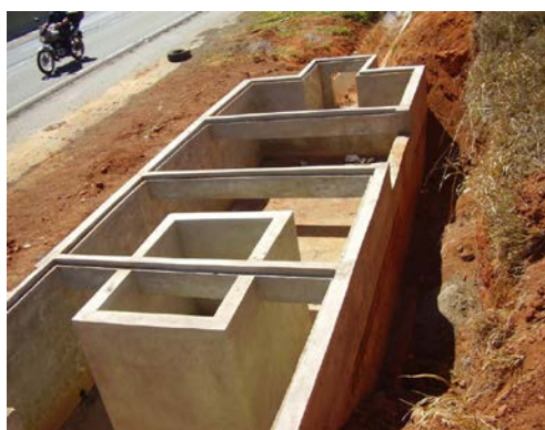
Figura 04 – Vista de uma das caixas de retenção, com o sifão, situada no vão central, entre as pistas. Fonte: PHELPS, Cláudio.
