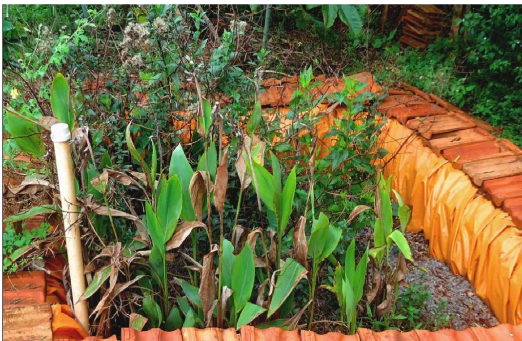
Figura 1 – Vista superior de uma estação de tratamento por zona de raízes instalada em uma propriedade rural no município de Peabiru PR.
