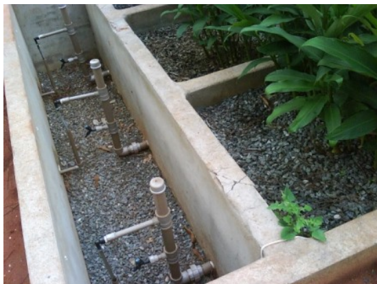
Figura 7 Detalhe do regulador de nível instalado na parte externa da tubulação de drenagem da estação experimental de tratamento de esgoto da unidade universitária EEC/UFG.
