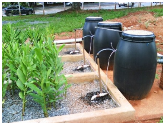
Figura 3 Detalhe das bombonas implantadas para controle de aplicação de esgoto nas zonas de raízes da estação experimental de tratamento de esgoto da unidade universitária EEC/UFG.
