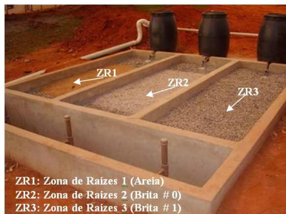
Figura 5 Detalhe de preenchimento dos leitos da estação experimental de tratamento de esgoto da unidade universitária EEC/UFG preenchidos com os substratos.
