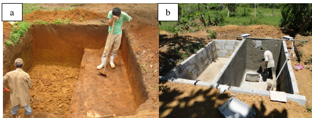
Figura 1. Abertura de valas (a); levantamento e reboco das paredes em bloco de concreto (b).
