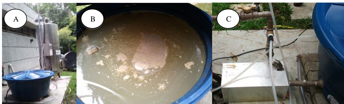
Figura 4 - Sistema de alimentação do biodigestor. (A) Conjunto caixa d'água e biodigestor; (B) Caixa d'água contendo resíduo e efluente; (C) Bomba centrífuga para alimentação do biodigestor com alta vazão.
