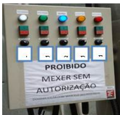
Figura 6 - Quadro de comando elétrico: (A) Chave que liga a bomba dosadora de alimentação auxiliar identificada pela cor branca; (B) Chave que liga sistema de agitação identificado pela cor verde; (C) Chave que liga bomba principal identificando pela cor azul; (D) Chave que liga a bomba imersa, identificada pela cor amarela; (E) Chave que liga a resistência identificada pela cor vermelha.
