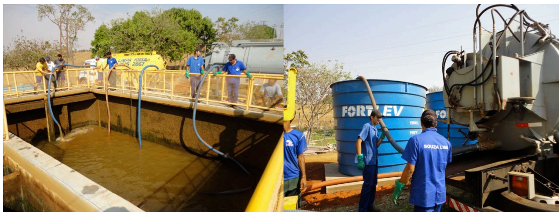
Figura 1: Coleta do resíduo do decantador por meio de caminhões com sucção a vácuo.
