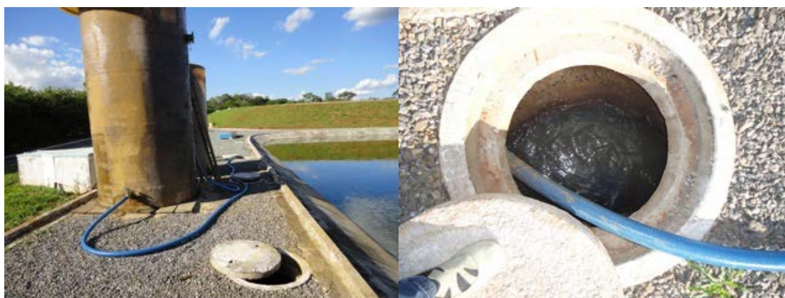
Figura 2: Aplicação do resíduo na lagoa - Tanque e mangote (à esquerda) e detalhe da caixa de entrada (à direita).
