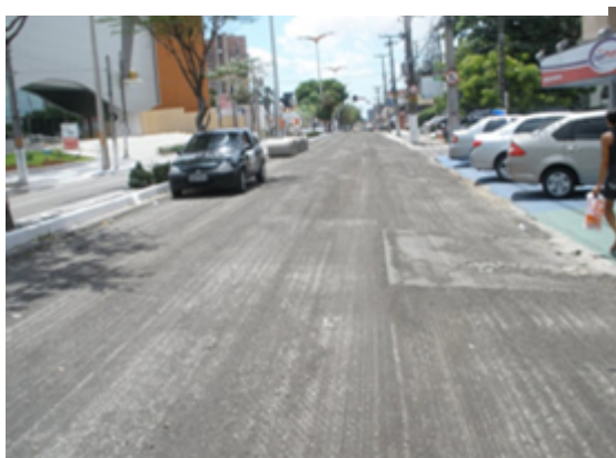
Figura 03: Fresagem entre as Ruas Monteiro Lobato e Eusébio de Sousa
