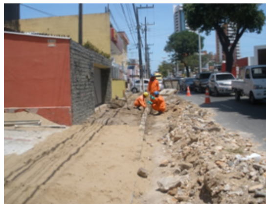
Figura 08: Demolição de calçada
