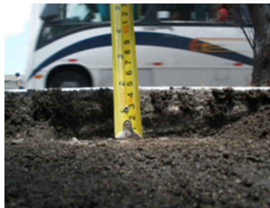
Figura 04: Espessura da camada asfáltica fresada.
