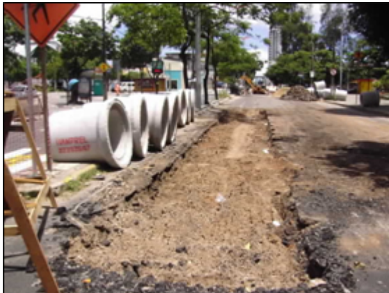
Figura 05: Demolição mecanizada do pavimento
