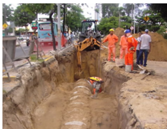
Figura 12: Escavação Mecanizada
