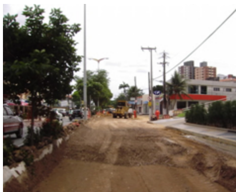
Figura 13: Execução de Base solo-brita
