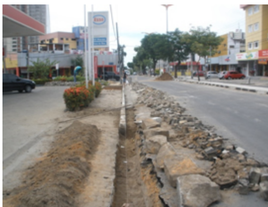
Figura 09: Retirada de meio-fio
