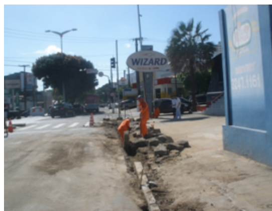
Figura 10: Retirada de meio-fio
