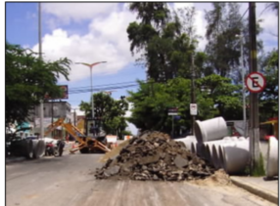
Figura 06: Resíduo sólido proveniente da demolição do pavimento
