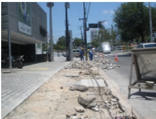
Figura 07: Demolição de calçada
