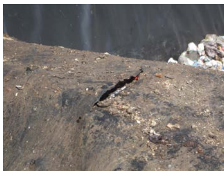
Figura 23: Manta impermeabilizante do aterro sanitário danificada.
