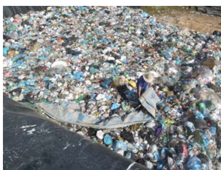
Figura 22: Operação de aterro sanitário sem Equipamentos de Proteção Individual (EPI).
