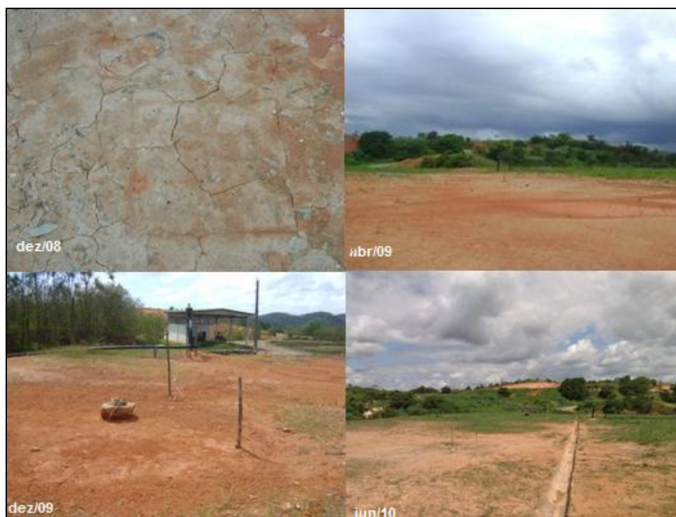
Figura 1: Fissuras superficiais e ausência de vegetação na camada convencional
