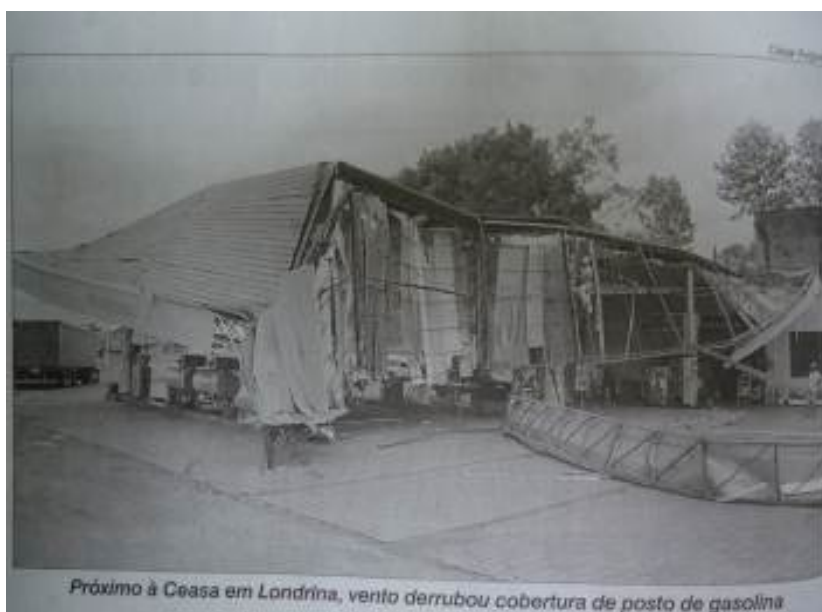
Figura 4: Posto de Gasolina com a cobertura derrubada pela ação do vento. Fonte: Jornal Folha de Londrina (2011).
