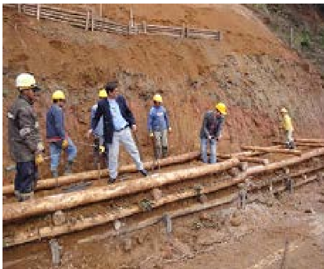
Figura 4: Instalação do live cribwall na base do talude.
