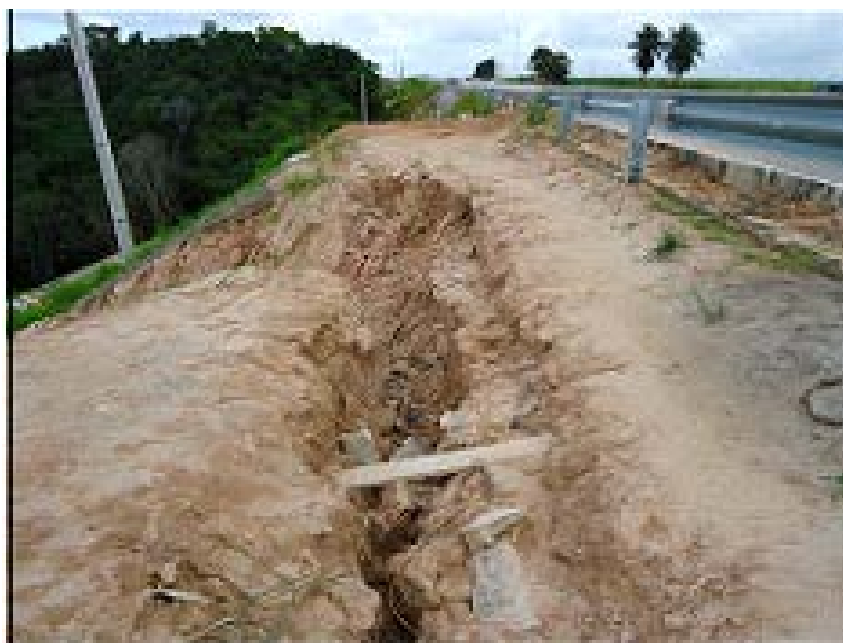
Figura 11: superfície contínua de ruptura, provocada pelo efeito hídrico no solo.
