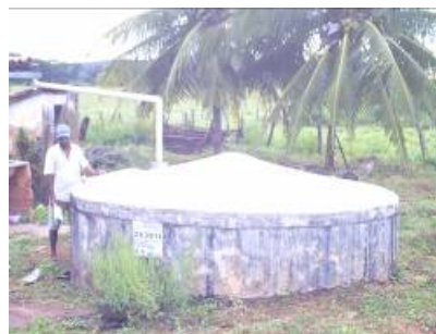
Figura 4: Exemplo de cisterna com condições de pintura e entorno ruins.
