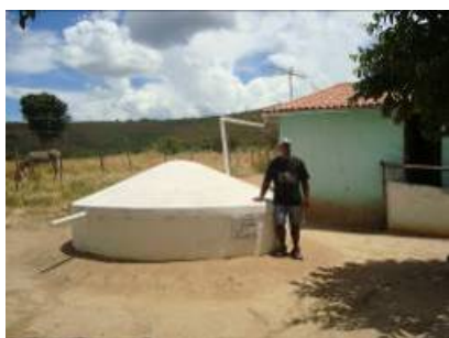
Figura 3: Exemplo de cisterna com condições de pintura e entorno boas.
