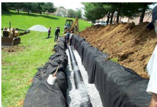
Figura 1 – Execução de uma trincheira Fonte: Ciria (2007)
