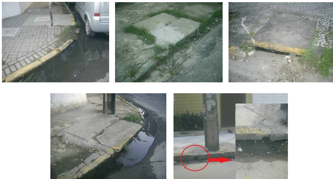
Figura 4: Condição de conservação da rede de microdrenagem, verificada na visita técnica do dia 09/07/2015. Fonte: As autoras.
