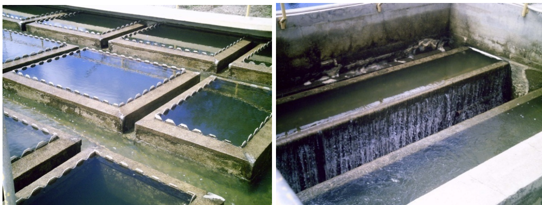
Figura 2. Foto dos decantadores e filtros rápidos da ETA Arcoverde
