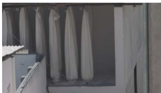
Figura 4: Filtros de manga para retenção de material particulado.
