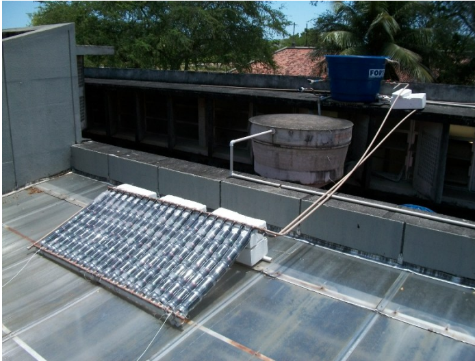
Figura 2: Protótipo do aquecedor solar instalado na Universidade Federal de Sergipe (coletor solar, caixa d'água em polietileno) e caixa d'água auxiliar de fibrocimento.
