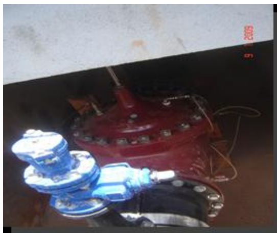
Figura 5: válvula redutora de pressão Em caixa subterrânea
