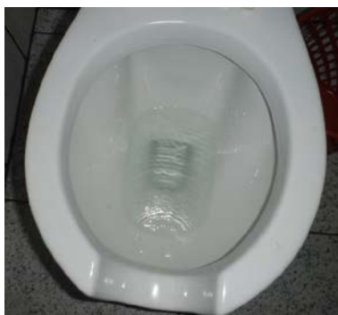
Figura 8 – Exemplo de falta de estanqueidade nos aparelhos de descarga de bacias sanitárias
