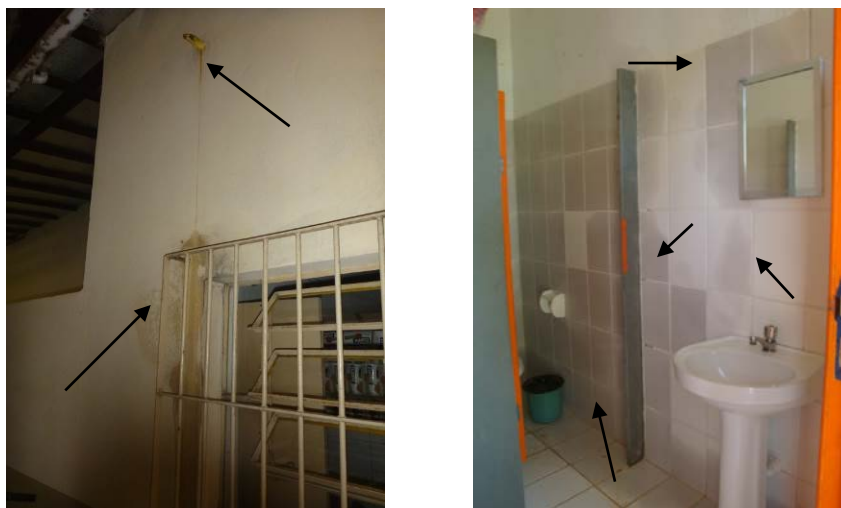
Figura 9 – Efeitos do vazamento de reservatórios sobre lajes
