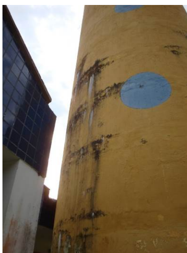
Figura 10 – Reservatório não estanque
