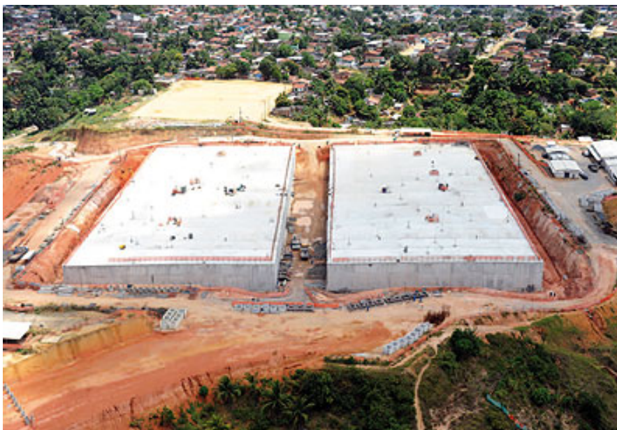
Figura 10 - Reservatório do Jordão dividido em duas câmaras
