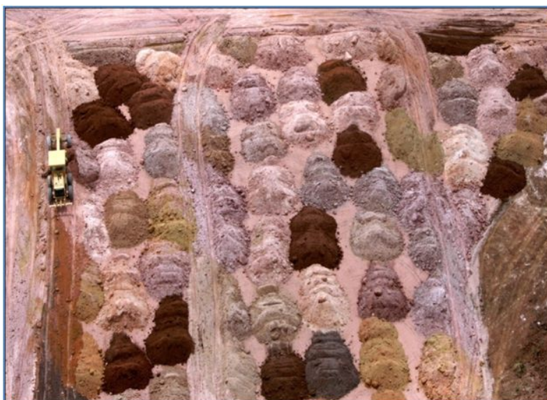
Figura 02: Lançamento de material em camada de aterro.
