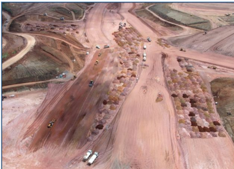
Figura 03: Espalhamento e homogeneização do material.
