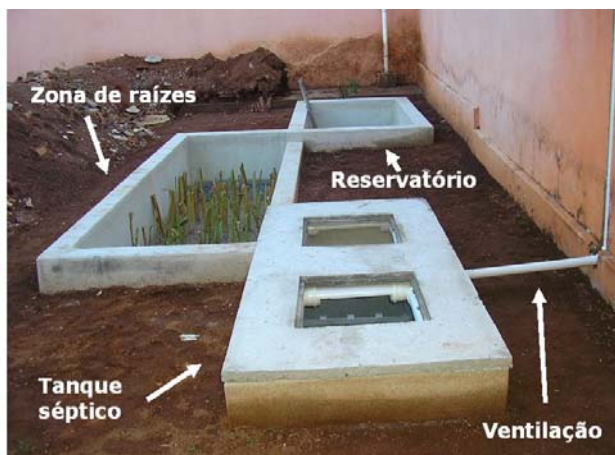
Figura 2: Vista geral do sistema residencial de tratamento de esgoto avaliado, em fase final de construção, ainda sem as tampas do tanque séptico e do reservatório. Goiânia, GO. 2008
