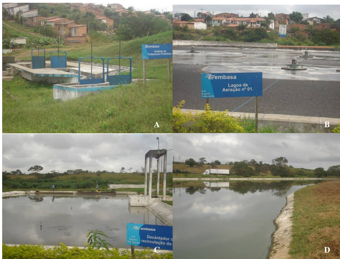
Figura 01: A - Etapa de tratamento preliminar na ETE Contorno; B - Vista geral da lagoa aerada 01; C - Vista geral do decantador secundário; D - Vista parcial da lagoa de sedimentação.
