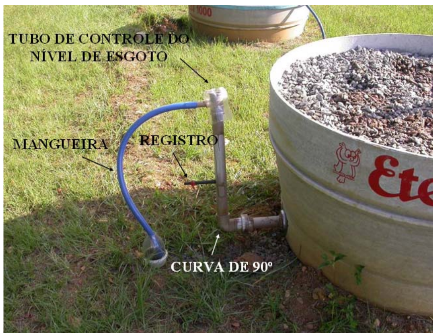
Figura 2: Parte externa do sistema de drenagem dos módulos finais de tratamento. Em detalhe o tubo de controle do nível de esgoto dentro da caixa e o registro amostrador.
