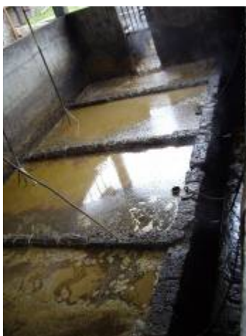
Figura 8: Caixa de gordura (fat-pit) do sistema de tratamento Fonte: Castro; Moruzzi; Oliveira (2008).
