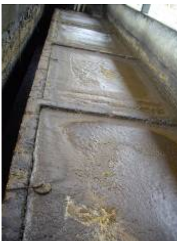
Figura 9: Detalhe da emulsão de óleo e água na caixa de gordura Fonte: Castro; Moruzzi; Oliveira (2008).
