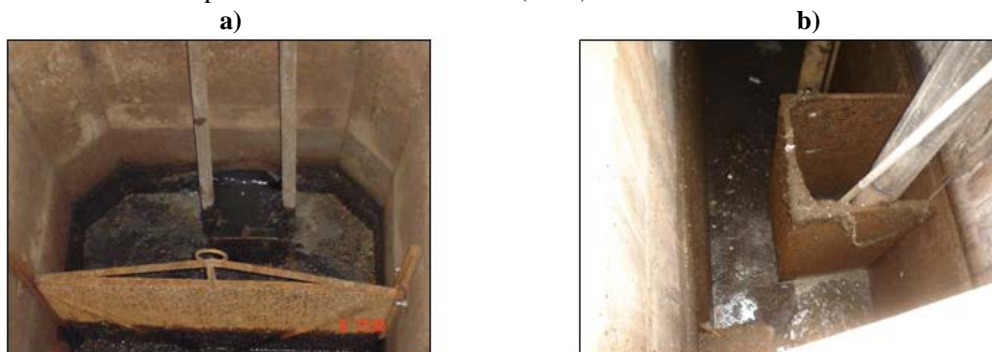
Figura 1 – Grade e Cesto no Poço de Sucção das Elevatórias de Esgoto.
