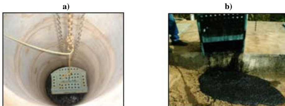
Figura 6 - Resultado da retirada do cesto na primeira manutenção em Glaucilândia.
