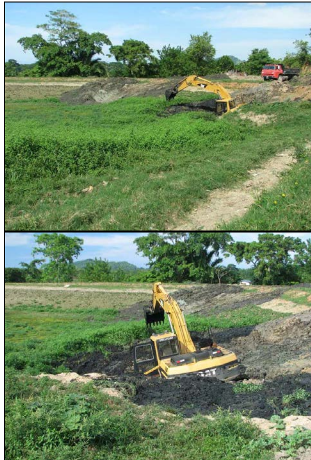
Figura 6: Remoção do lodo sólido ( TS_0 \geq 18\% ) pela escavadeira, em setembro, dois meses após a drenagem da lagoa. A consistência de lodo era sólida até 1,0m ou mais de profundidade, permitindo que a escavadeira manobrasse sem dificuldade.
