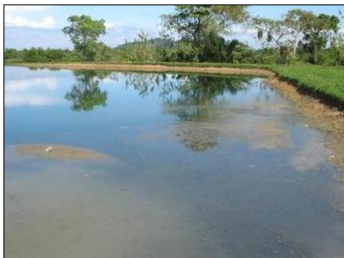
Figura 3: Entrada da lagoa primária (2007) e surgimento na superfície da lagoa de parte do lodo que estava a 4,0m de profundidade. Neste momento, foi estimado que o volume de lodo era de 3.500\text{m}^3 e ocupava 50% do volume da lagoa.
