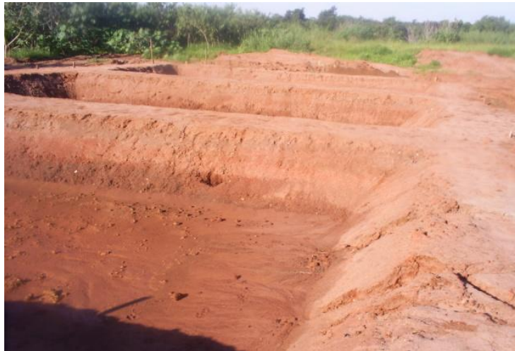
FIGURA 3: Escavação do terreno para montagem do leito
