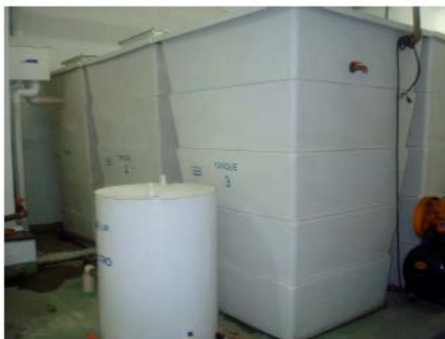
Figura 2: Estação de Tratamento de Águas Cinza – ETAC.
