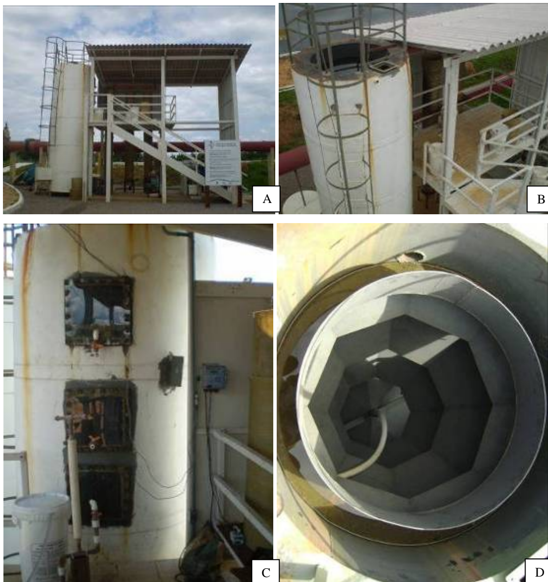
Figura 3: Fotos do protótipo de reator UASB instalado na ETE Vila União, Palmas, TO.
