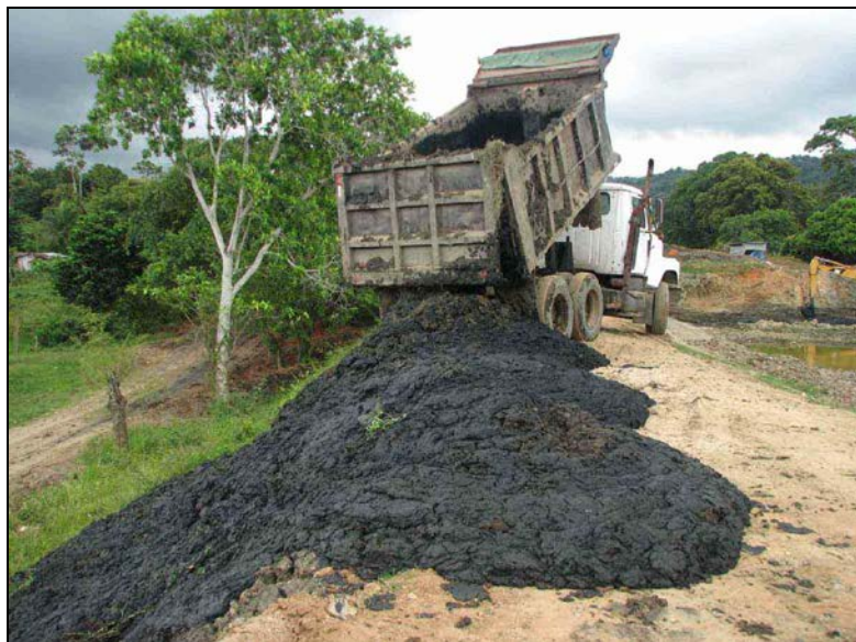
Figura 8: Descarte do lodo sobre um dos taludes da lagoa primária.
