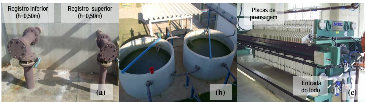
Figura 3: (a) Tubulações de descarte de lodo na lateral dos reatores UASB; (b) Tanques de armazenamento de lodo; (c) filtro prensa
