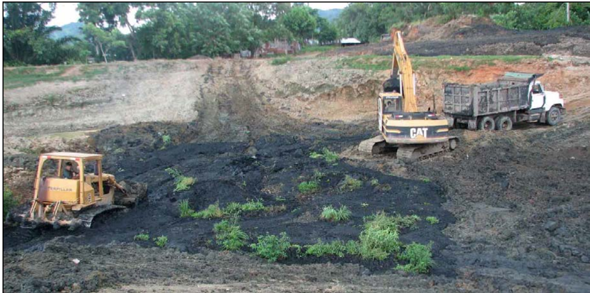
Figura 7: Após remoção da camada superior do lodo, foi usada uma combinação escavadeira/pá carregadeira para retirar a camada inferior do lodo (camada semilíquida).
