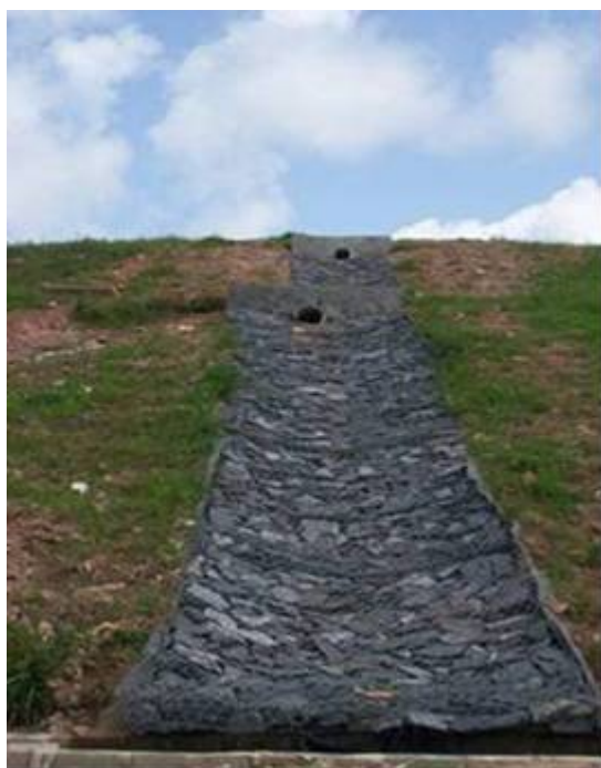
Figura 3: Sistema de Drenagem de Água Pluvial em Colchão Reno.
