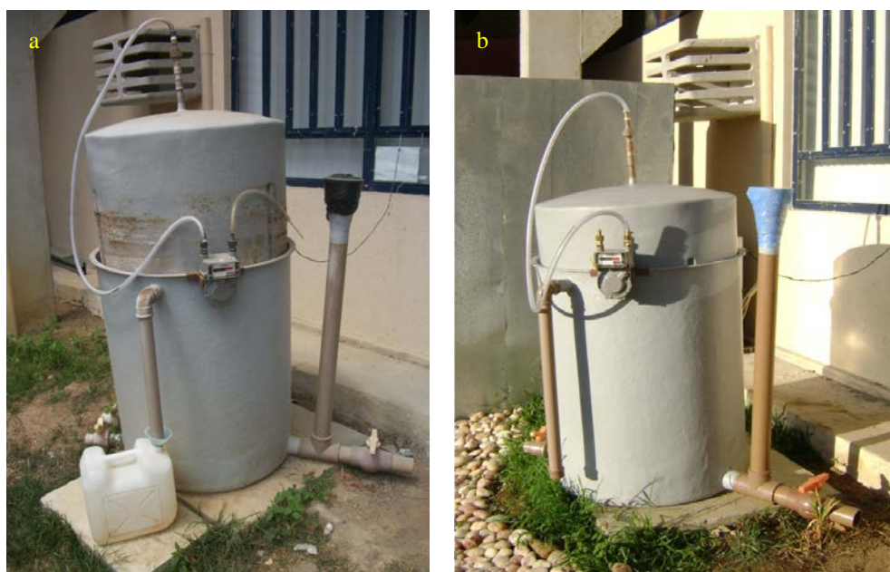
Figura 2. Deslocamento do cilindro superior do biodigestor devido ao acúmulo de biogás (a), em relação à posição anterior (b).
