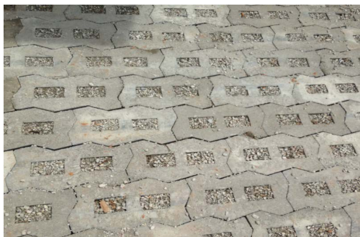
Figura 4: Piso permeável utilizando agregado reciclado.
