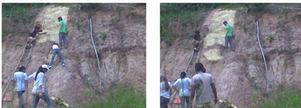
Figuras 4 e 5: Aplicação da biomanta na Alça Viária. Fonte: Os autores, 2008
