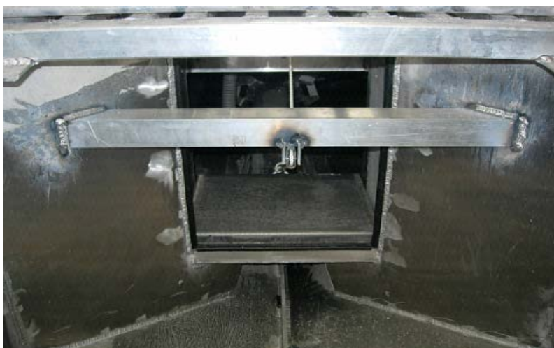
Figura 6 – Skimmer aberto para despejo da água oleosa retida no tanque.
