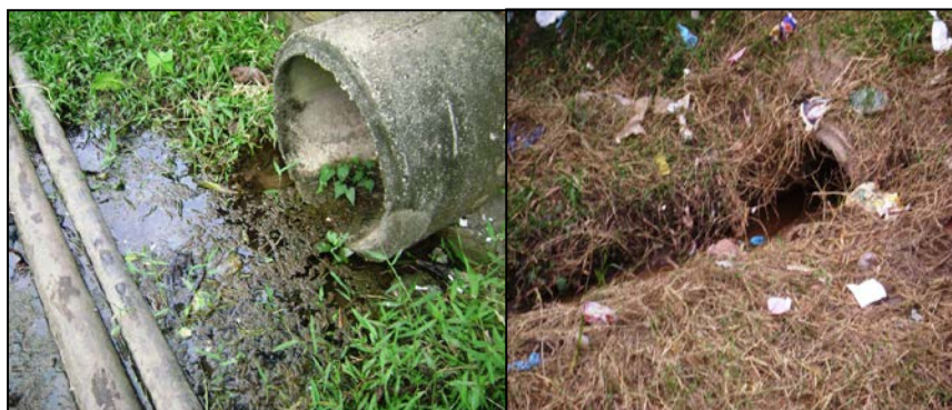
Fotografia 2 – esgoto sendo lançado diretamente para o corpo receptor (igarapé). Fonte: autor (2010).
