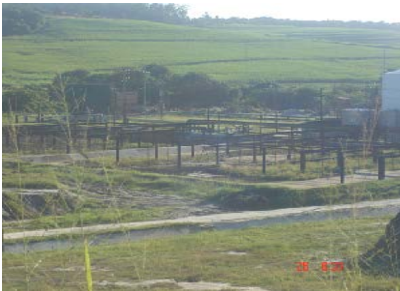
Figura 3: Lagoa para estabilização de águas residuárias. Acervo do autor.
