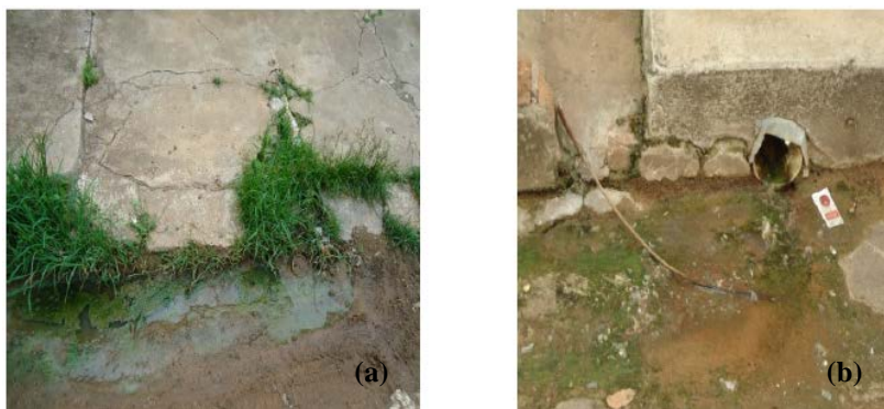
Figura 4 (a);(b): Lançamento de esgoto a céu aberto.
