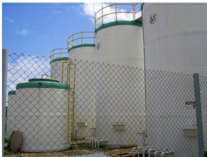
Imagem 03: Estação Modular de Tratamento de esgoto
