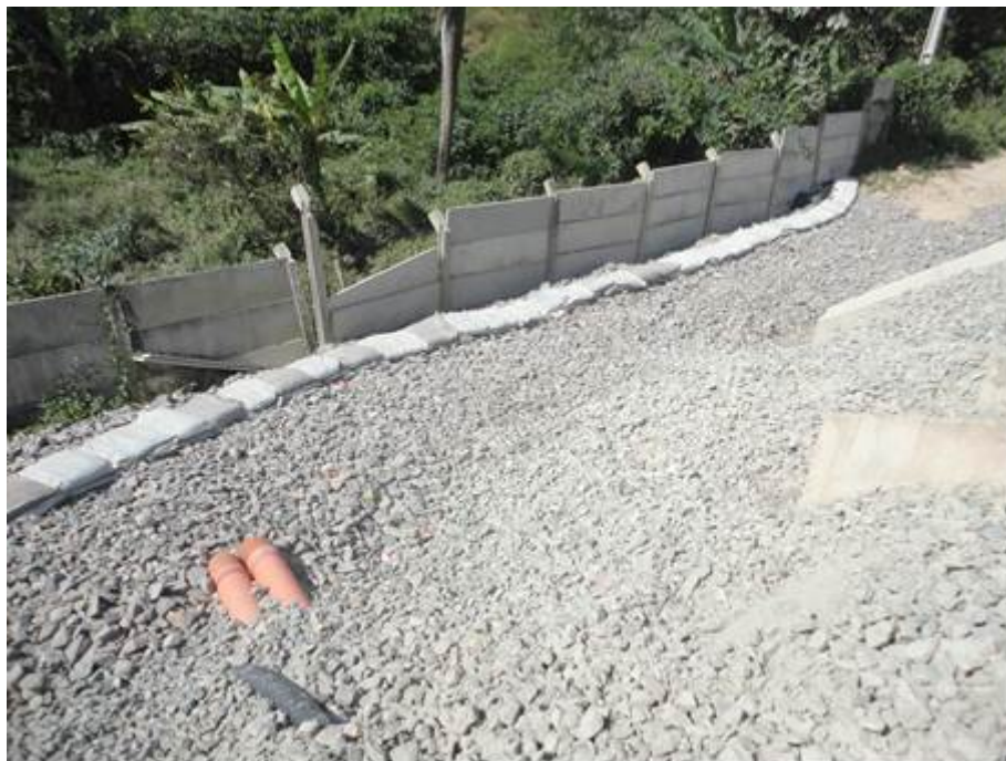
Figura 02: Cerca Filtrante
