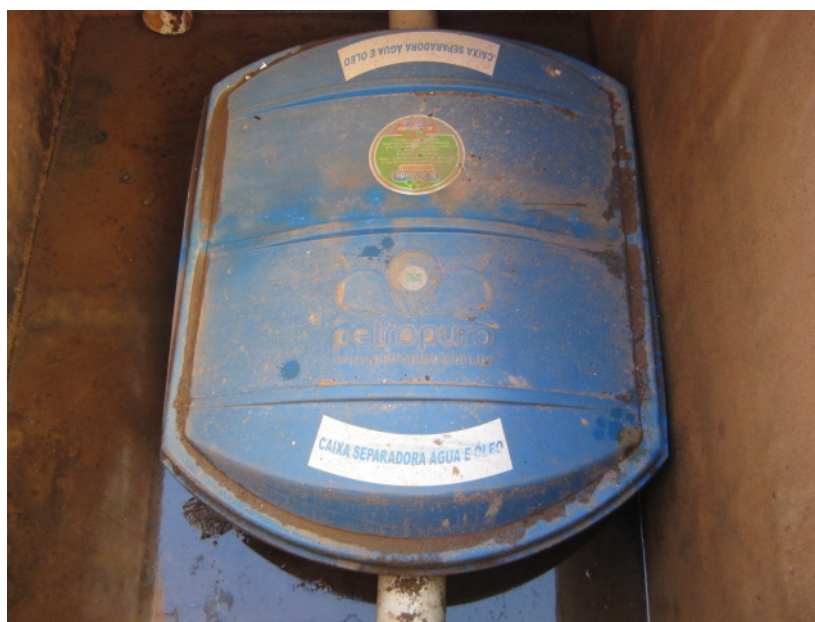
Figura 9: Caixa Separadora de água e óleo, Concessionária de veículos, Aparecida de Goiânia, GO.
