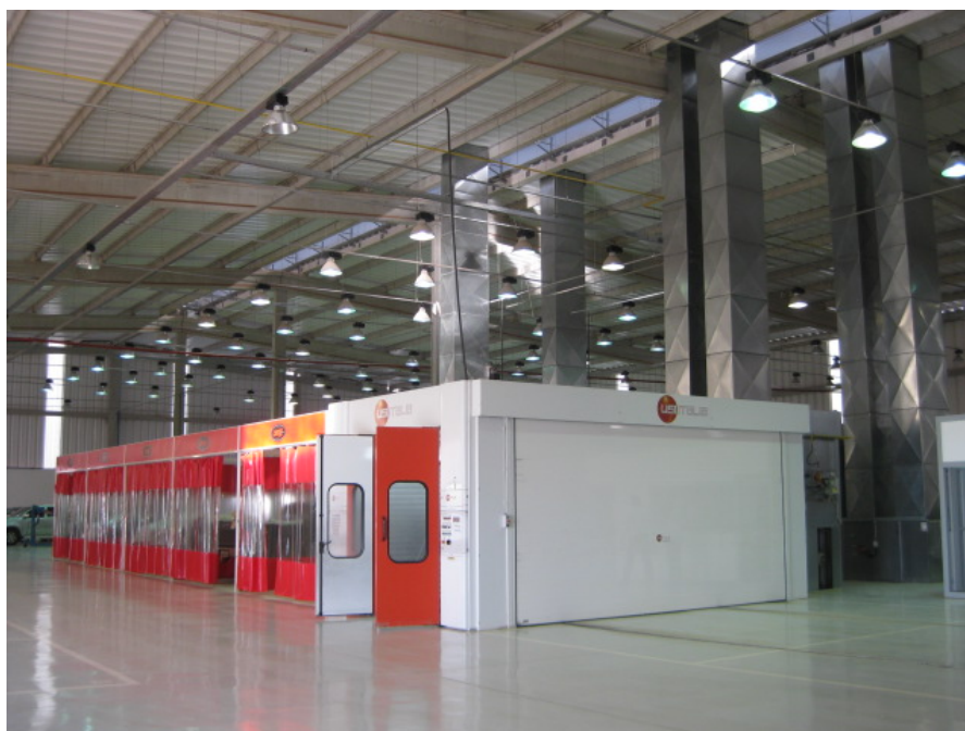
Figura 7: Cabine de pintura e dutos com filtros, Concessionária de veículos, Aparecida de Goiânia, GO.
