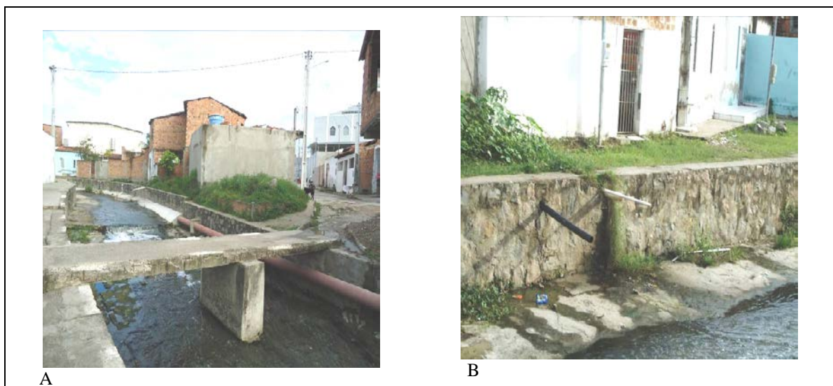
Figura 4 Lançamento de esgoto doméstico pelos moradores das residências vizinhas ao córrego no Município de Feira de Santana- BA./Brasil: (A) vista panorâmica e (B) close nas tubulações que despejam esgoto doméstico no córrego.
