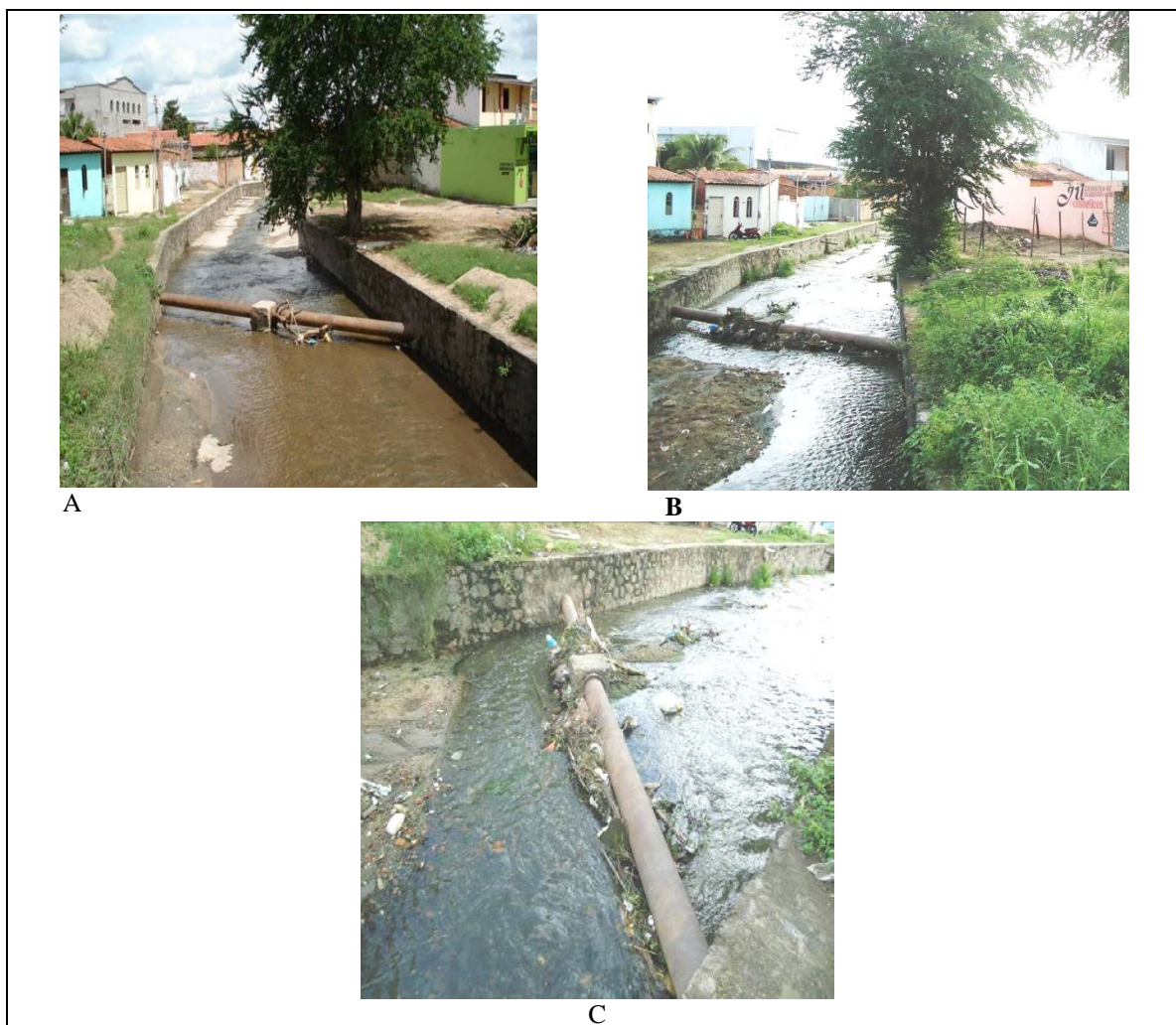
Figura 3 Córrego com resíduo material arenoso e outros resíduos sólidos interferindo no fluxo natural da água, próximas a córregos no Município de Feira de Santana-BA/Brasil: (A) registro de presença de resíduo de construção civil e outros no interior do Córrego em 2009; (B) aumento do volume e maior quantidade de resíduo arenoso no córrego em 2011 e (C) detalhe da figura 3B, mostrando o desvio do fluxo da água modificado pela presença de resíduos domésticos, de construção civil e outros em 2011.
