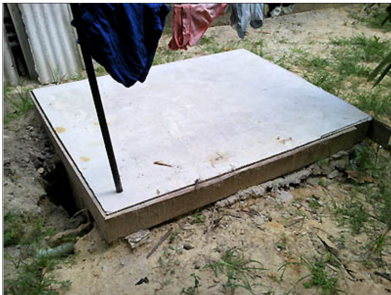
Figura 4: Fossa construída sem orientação técnica.
