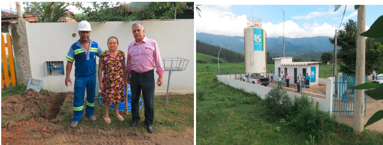
Fotos 01 e 02: cliente beneficiada com a primeira ligação de água (esq) e sistema de produção e distribuição de água (dir).
