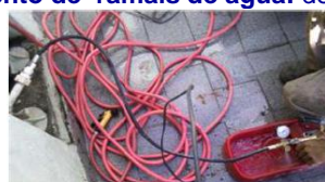
Figura 2 – Teste de estanqueidade
