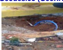
Figura 1 – Substituição da corrida do cavalete
