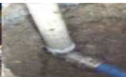
Figura 1 – Substituição da corrida do cavalete
