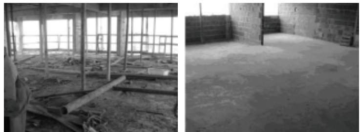
Figura 2 e 3 – Limpeza dos Pavimentos, antes e depois.
