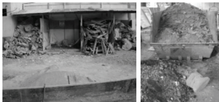
Figura 8 e 9 – Segregação Final dos Resíduos Classe B (papel, plástico, madeira e metal) e caçamba com Resíduos Classe A (metralha) nos Canteiros de Obras.
