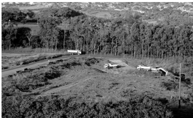
Figura 4 - Expansão do Aterro sanitário de Goiânia (Fonte: Prefeitura de Goiânia)
