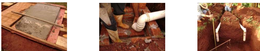
Figura 5: Etapas executadas no segundo dia de oficina (fonte: Habis, 2009).
