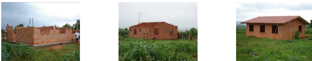
Figura 1: Habitações em processo de construção e habitação com cobertura (fonte: Habis, 2007).
