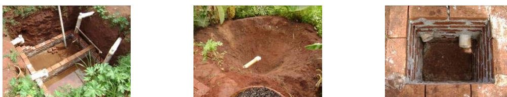
Figura 6: Etapas executadas no segundo dia de oficina (fonte: Habis, 2009).
