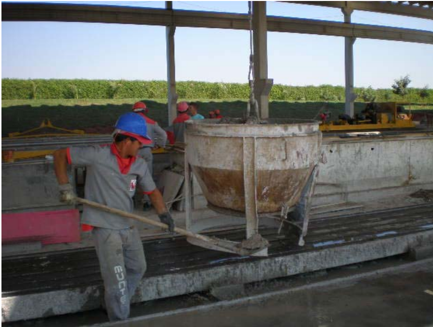
Figura 9: Limpeza da pista de concretagem.
