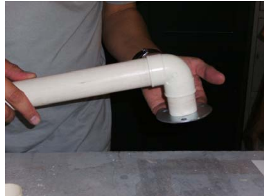
Figura 14: prolongamento da curva com um pedaço de tubo e a chapa de fixação.
