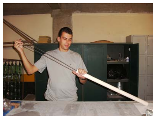
Figura 12: inserção de ferro dobrado, no interior do tubo de PVC.
