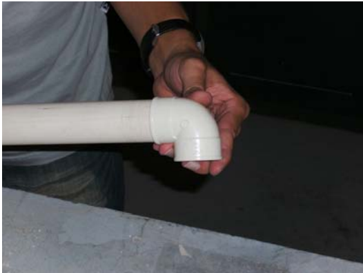
Figura 13: união do cotovelo de 90° ao tubo de 80cm.
