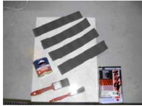
Figura 8: material necessário para tornar o piso antiderrapante. Fonte: própria, 2008.
