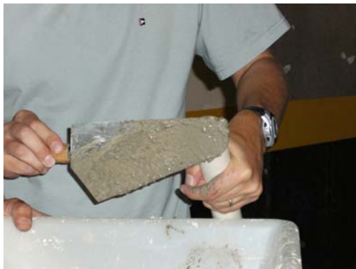
Figura 15: inserção de concreto no interior do tubo de PVC.
