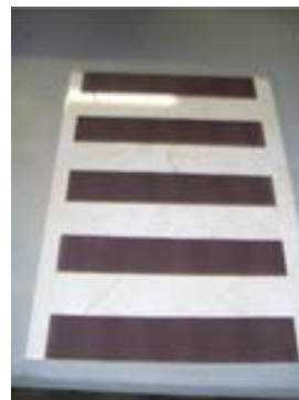
Figura 10: piso acabado, com aplicação de resina para impermeabilização. Fonte: própria, 2008.
