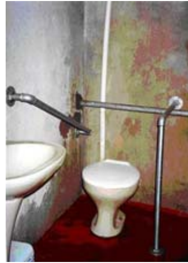
Figura 4: foto das barras de apoio instaladas. Fonte: VIZIOLI, 2003
