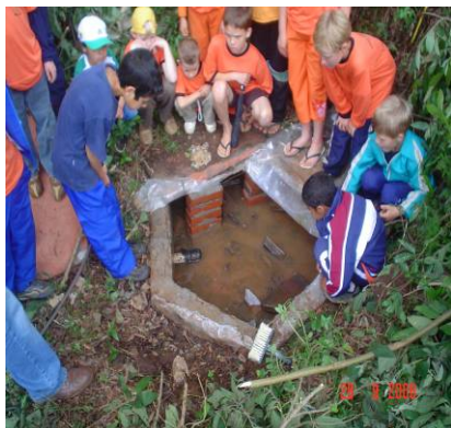
Proteção de nascente
