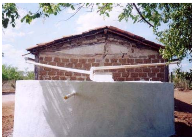
Figura 01: Cisterna de placa, forma de captação e armazenamento de água de chuva.
