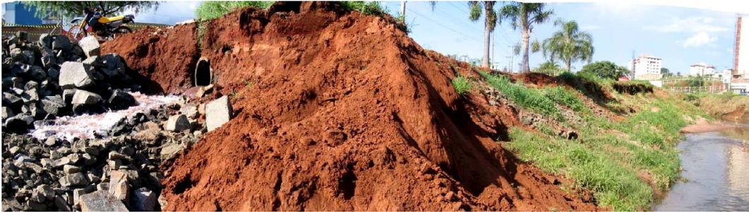
**Figura 1: ruptura de interceptor de esgoto sanitário**
