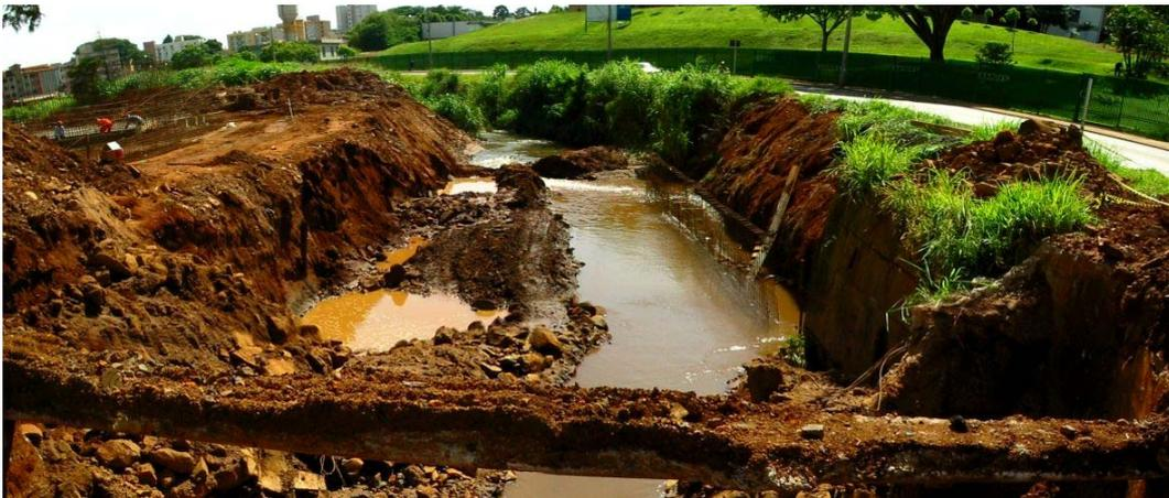
**Figura 2: implantação de sistema viário e impactos sobre Áreas de Preservação Permanente – perda de solo e assoreamento de córregos**
