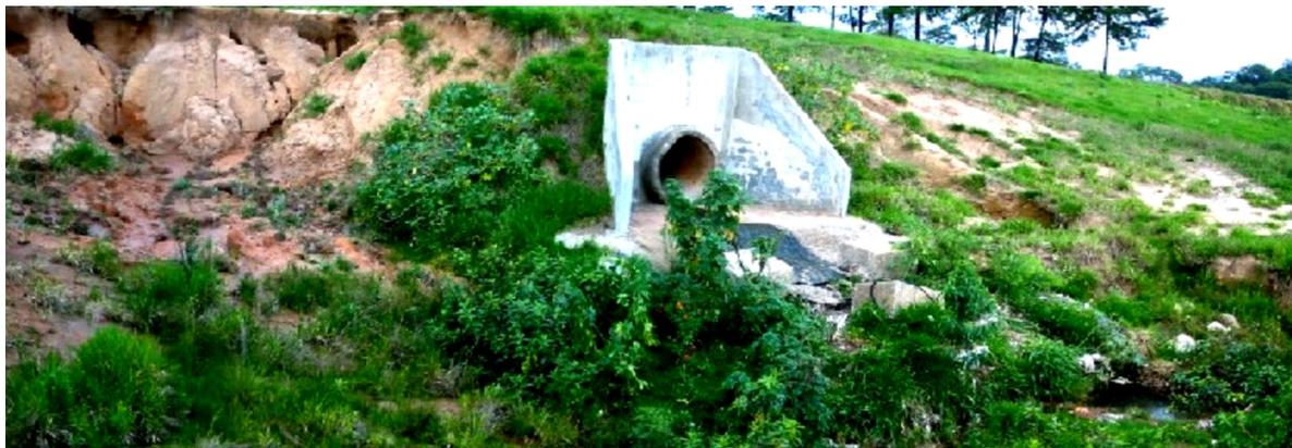
**Figura 4: dispositivo de drenagem superficial causando erosão e degradação em córregos**
