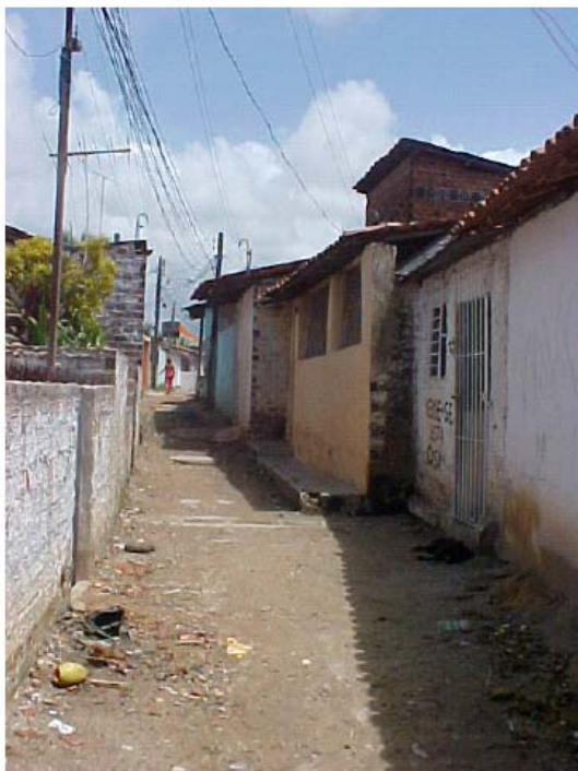
Figura 5: R. Waldemir Telles antes das obras.
