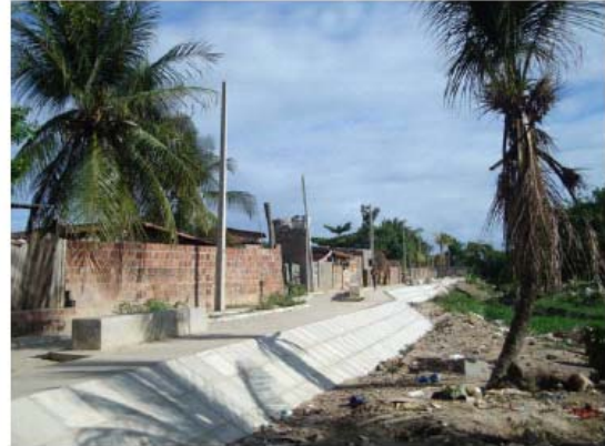
Figura 4: Rua Beira Rio depois das obras.
