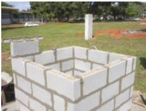
Figura 4: Experiência da UnB com o uso do entulho da construção para a produção de moradias populares.
