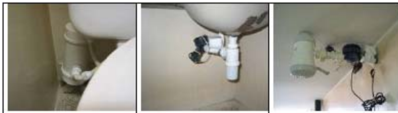
Figura 15 – Equipamento (hidrômetro+datalogger) instalado em uma caixa acoplada; lavatório e chuveiro).
