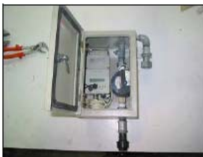
Figura 6 – Caixa de medição com o conjunto de hidrômetro+”datalogger” no cavalete de entrada da residência.
