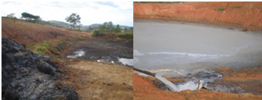
Figura 1: Lagoas aeróbias em manutenção e em funcionamento para tratamento da manipueira.
