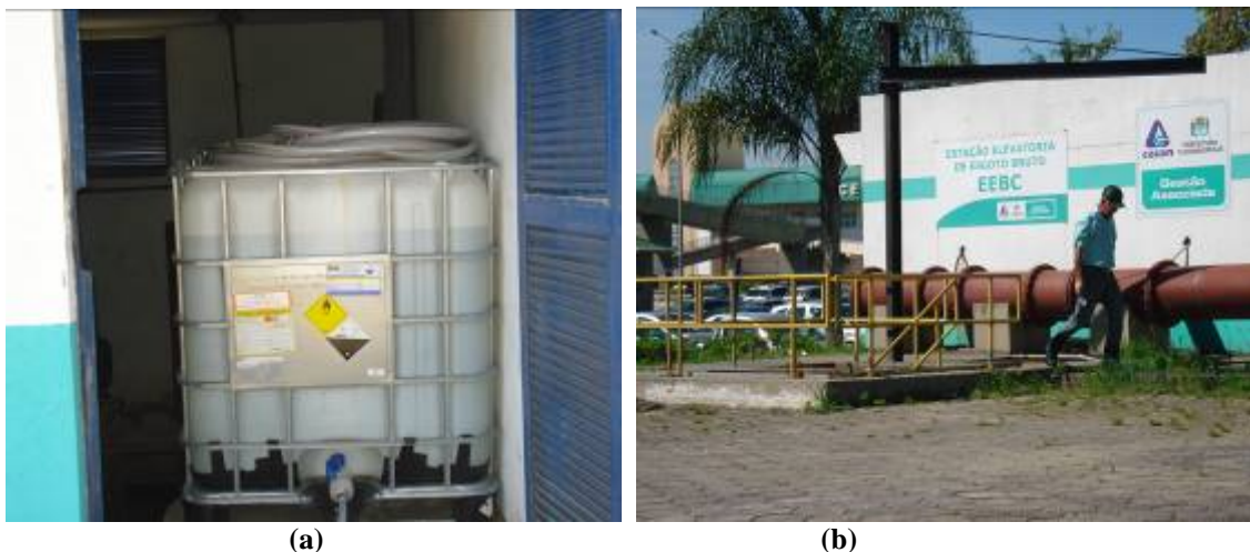
Figura 4: Tanques (IBC) de armazenamento do produto (a) e vista da EE-BC (Sacolão) (b).
