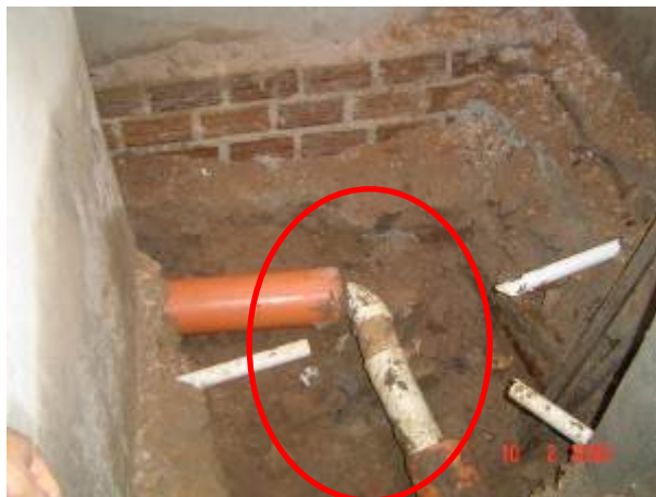
Figura 4 - Arranjo realizado pelos pedreiros
