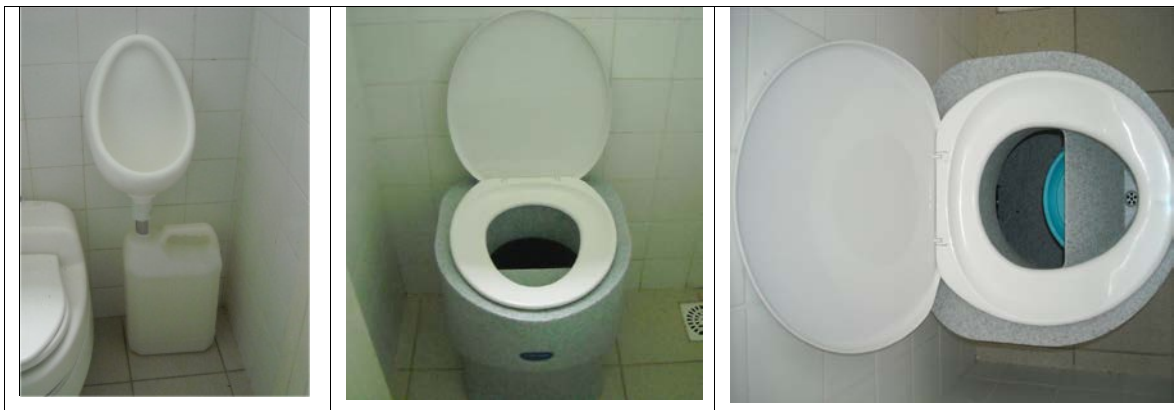
Figura 4: conjunto de imagens do mictório e sanitário separador de excretas instalados nos banheiros masculino e feminino do Departamento de Engenharia Hidráulica e Ambiental (DEHA) – UFC.
