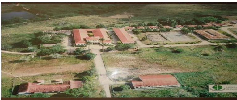
Figura 1: Vista aérea do Instituto Federal de Educação, Ciência e Tecnologia de Sergipe - Campus São Cristóvão. Fonte: IFS-Campus São Cristóvão, 2007.
