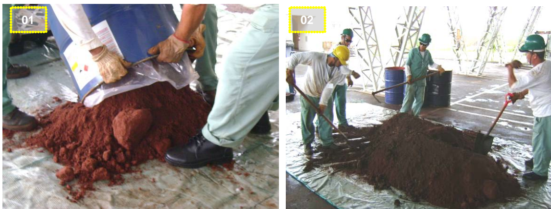
Figuras: 1 e 2 – Solos impregnados com óleo mineral, em trabalho de homogeneização.
